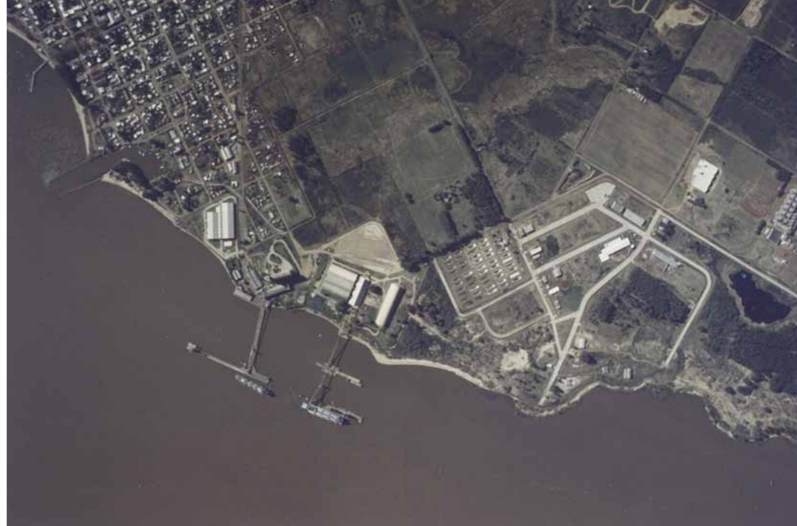
Terminal Nueva Palmira
