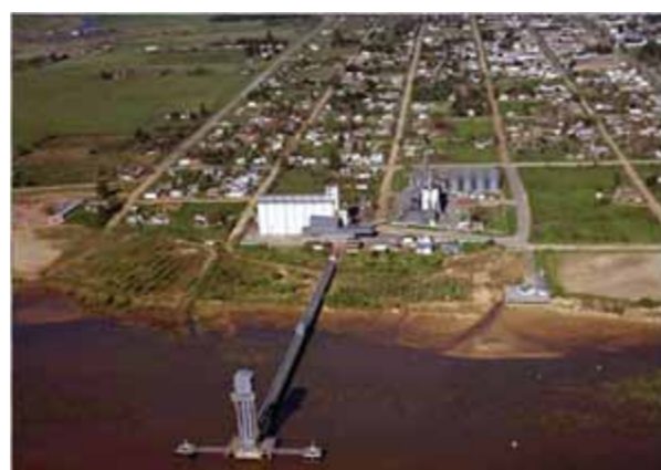
Terminal Nueva Ramallo
